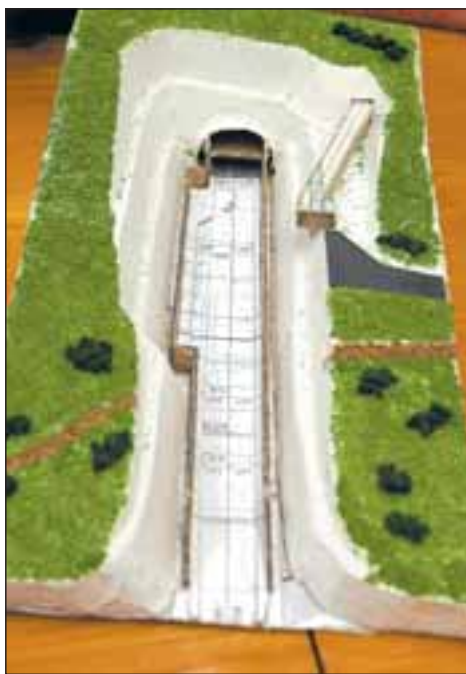
Die Tunnelbaustelle gräbt sich am Westportal immer tiefer in die Erde. Das Modell veranschaulicht den Bau der ersten 80 Meter des Tunnels in offener Bauweise (l.). Nach Abschluss der Maßnahme wird nur noch ein Teil des Betriebsgebäudes zu sehen sein (r.). Fotos: Dorn (l)/Kreutzer
