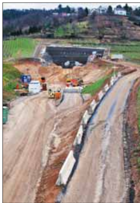
Die Tunnelbaustelle gräbt sich am Westportal immer tiefer in die Erde. Das Modell veranschaulicht den Bau der ersten 80 Meter des Tunnels in offener Bauweise (l.). Nach Abschluss der Maßnahme wird nur noch ein Teil des Betriebsgebäudes zu sehen sein (r.). Fotos: Dorn (l)/Kreutzer
