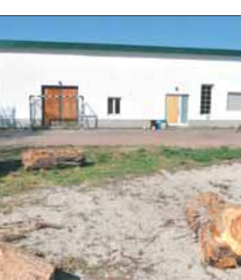
Verlassen sieht das Push-Gelände aus: Das Jugendhaus war früher die Fabrikhalle des Unternehmers Busch. Foto: Dorn
