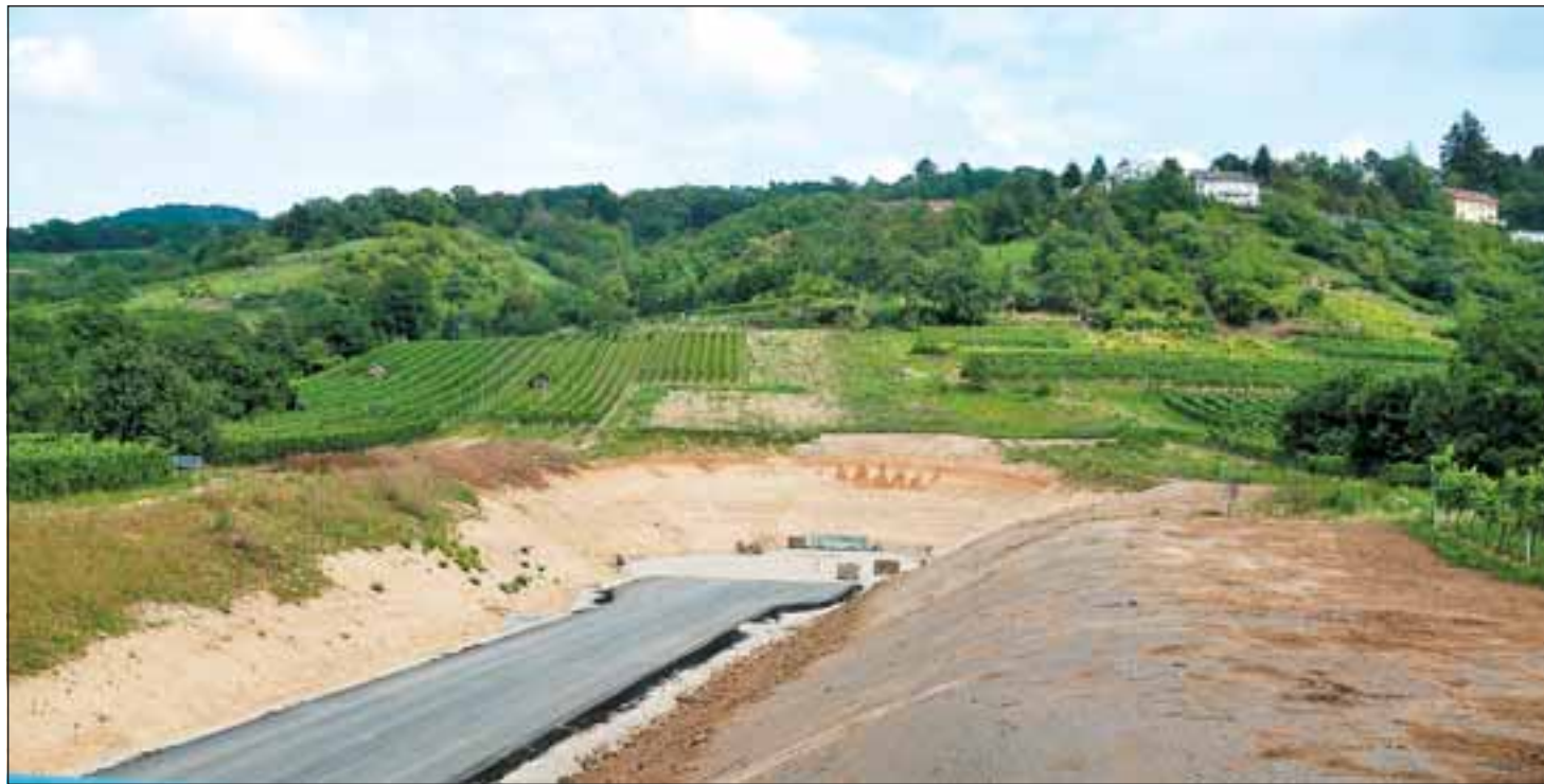
Hier wird das westliche Tunnelportal entstehen. Nicht nur die kalkulierten Kosten für den Tunnelrohbau laufen schon vor dem Baustart davon. Auch das Volumen des Gesamtprojekts „Branichtunnel“ wurden deutlich nach oben korrigiert. Sollte alles zunächst 63 Millionen Euro kosten, veranschlagt das Land jetzt rund 85 Millionen Euro für das momentan teuerste Projekt im Landesstraßenbau. Foto: Dorn
