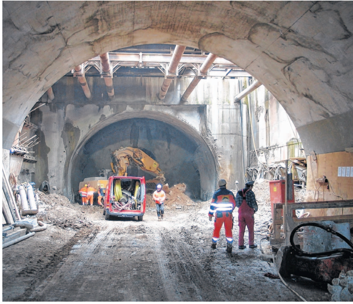
So weit wie hier beim Tunnel in Neckargemünd sind die Arbeiten am Branich-Tunnel noch lange nicht. Doch der erste Schritt ist gemacht: Nach der Ausschreibung genehmigte der neue Minister die Erteilung des Bauauftrages für die Tunnelröhre. BILD: ARCHIV
